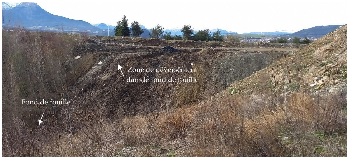
Photographie 5 : Vue sur la zone en cours de remblaiement
