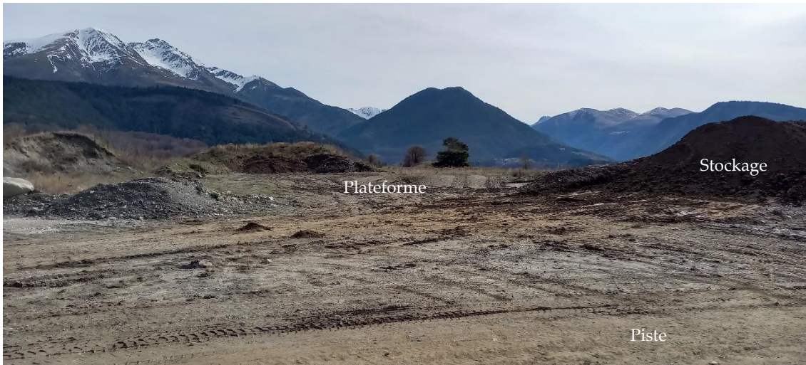
Photographie 2 : Plateforme d'accueil des matériaux
