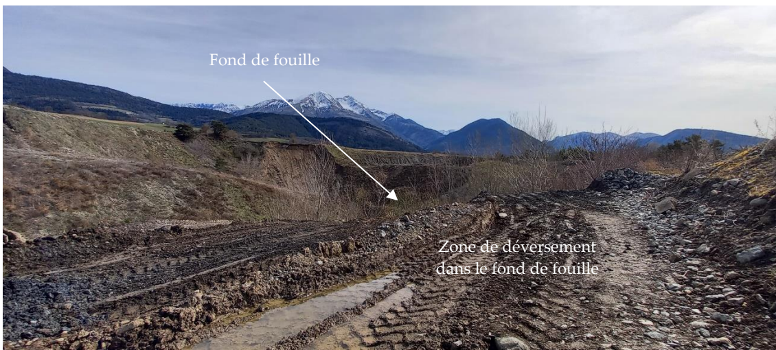
Photographie 4 : Prise de vue depuis la zone de déversement dans le fond de fouille
