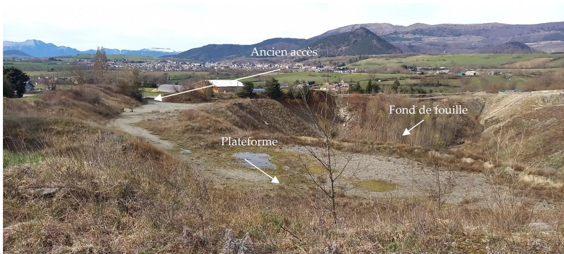
Photographie 8 : Plateforme au droit de l'ancien accès
